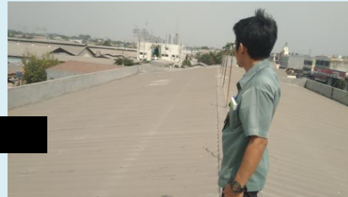
POTENSI PLTS ATAP Pengecekan area potensial pemasangan PV rooftop...
