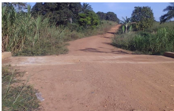
Photo 1 : Construction d'un Dalot dans un quartier péri urbain de Lola (Région de N'Zérékoré)
