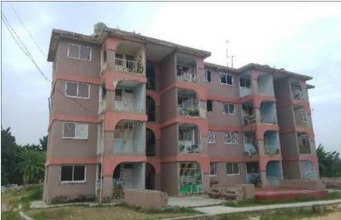
FOTO 30: Vista frontal Edificio Cero Emisión, Cuba, noviembre de 2016.
