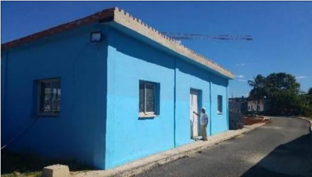
FOTO 22: Casa de compresores del sistema de aireación en la Planta de Tratamiento de Aguas Residuales Luyanó IV, Cuba, noviembre de 2016.
