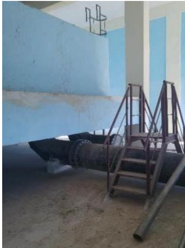
FOTO 14: Pre Tratamiento. Tubería de aguas residuales preparadas para el futuro montaje de las 2da. Y 3ra. Etapas, en la Planta de Tratamiento de Aguas Residuales Luyanó IV,
