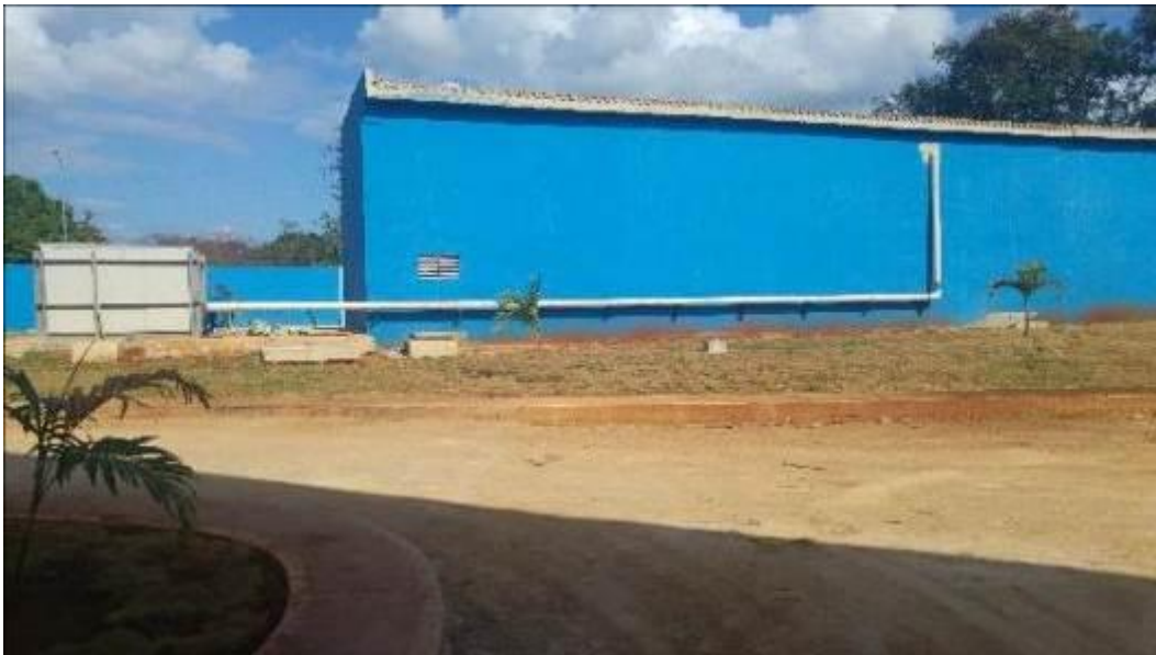
FOTO 24: Estación de Bombeo Principal y biofiltro 1 de la Planta de Tratamientos de Aguas Residuales Luyanó IV, Cuba, noviembre de 2016.
