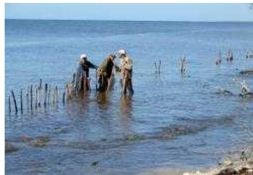
Figura 3. Empalizadas que se establecen en el agua para reducir la fuerza del oleaje y fomentar el crecimiento del mangle rojo.
