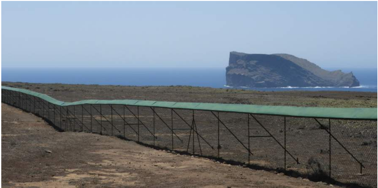
Cerco exclusivo para gatos en Punta Sur, RB Isla Guadalupe, Proyecto de control de gato feral 14-04-2018
