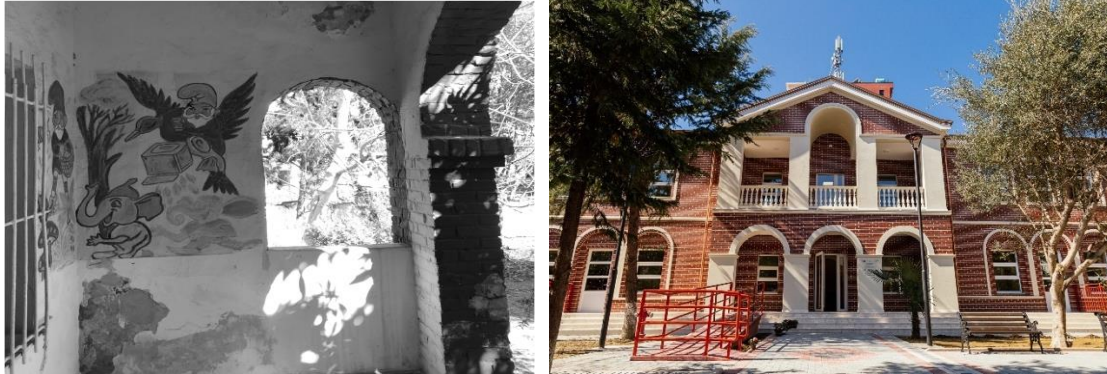
(1) "1 Qershori" Kindergarten, Durrës (repair)
