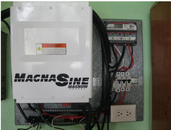
Sistema #1. Tablero con inversor de 2 kW,
