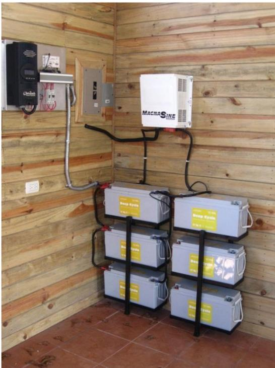
Vista de tablero con regulador Outback (izquierda arriba), inversor de 2 kW (derecha arriba), banco de baterías
