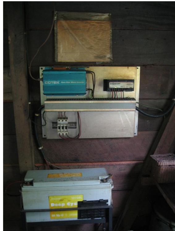
Tablero con Inversor de 300 W (superior izquierdo), Regulador de carga (superior derecho), regleta de conexiones (centro) y breaker (inferior izquierda). Batería de 150 Ah de gel de descarga profunda, montada sobre base metálica.
