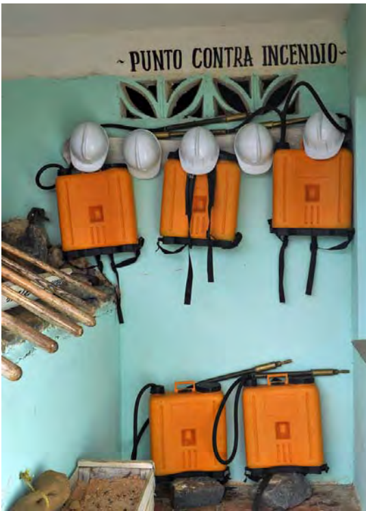
Equipamiento de lucha contra el incendio
