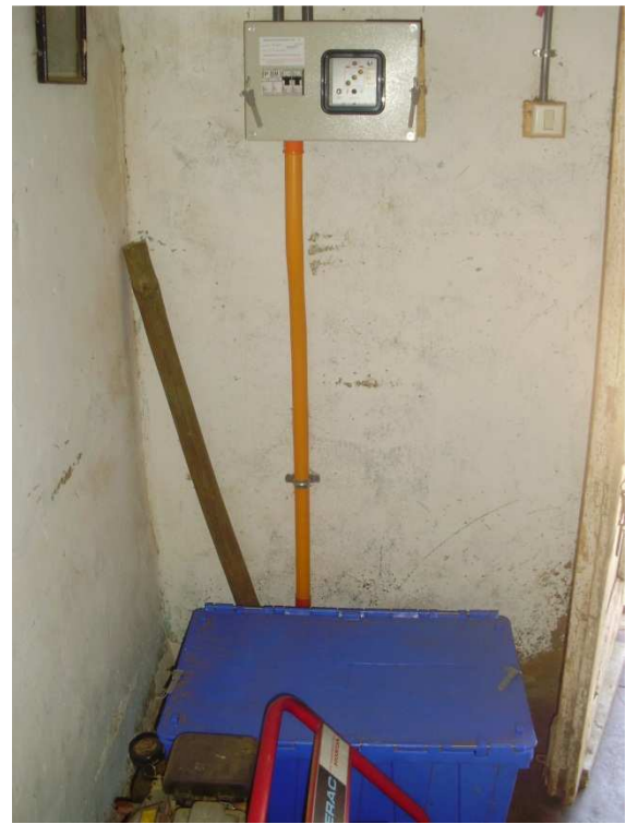
Caja de batería. Observar para evitar acceso del usuario a la batería
