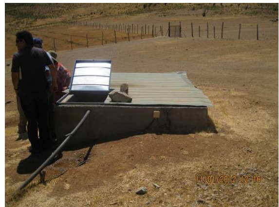
Tanque almacenamiento de 7 m3
