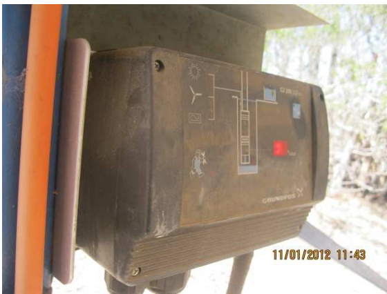
Regulador del sistema de bombeo GRUNDFOS
