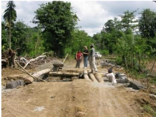
Fig. 9. Box Culvert Work
