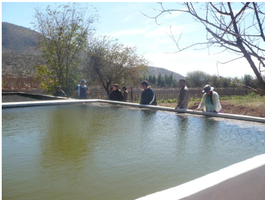
Productores/as de la comunidad Abra de la Cruz en el municipio de Padcaya en Tarija, visitan un estanque de almacenamiento de agua para microriego construido con apoyo de IICCA en el marco de los Fondos Concursables.
