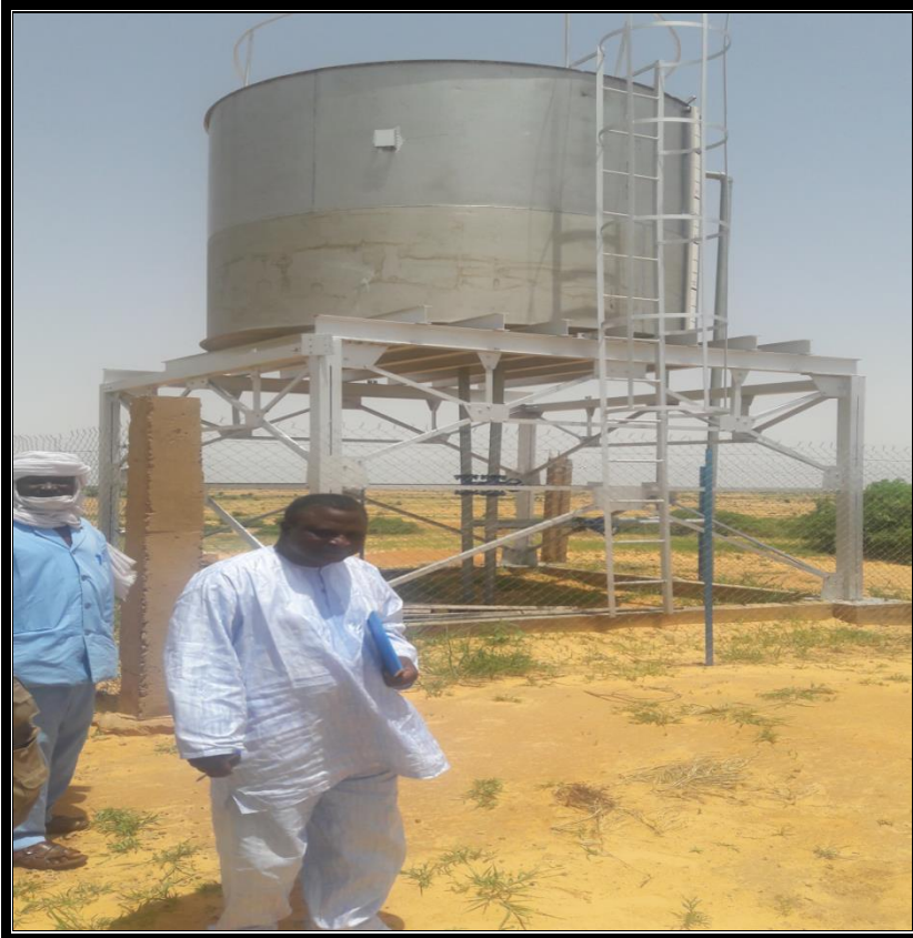
Figure N° 4 : Mini AEP de Tanout, construite en 2015 par le projet
