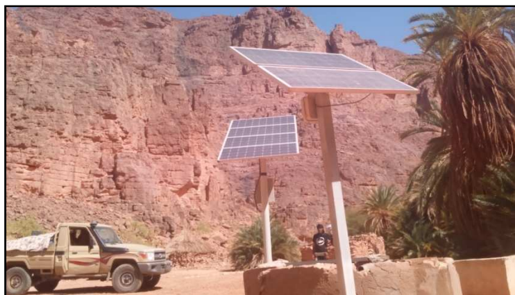
Figure 4. Energie solaire pour le pompage de l'eau à Aharhar
