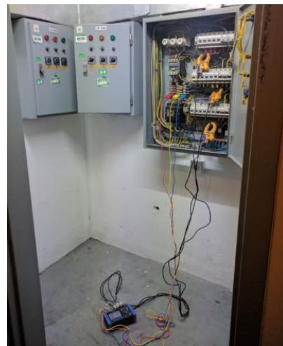
Gambar 2.8 Pengukuran Spot Beban Lampu pada setiap Lantai
