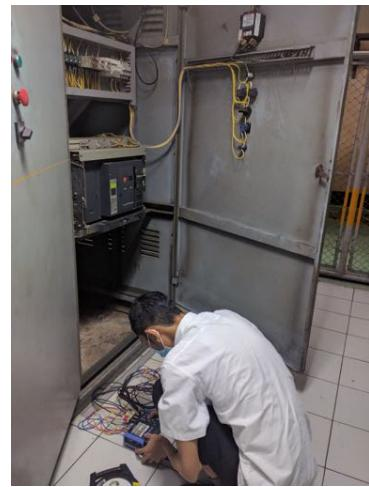
*Gambar 2.5 Pengukuran Daya Listrik on-line pada Panel LVMDP*
